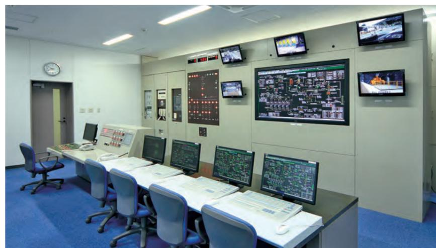
焼却炉の運転、ごみクレーン操作、公害対策機器の監視・制御などすべての管理を行っています。
