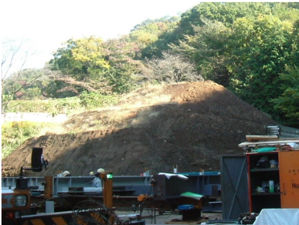
図3.2-5 埋め戻し用の残土置き場
