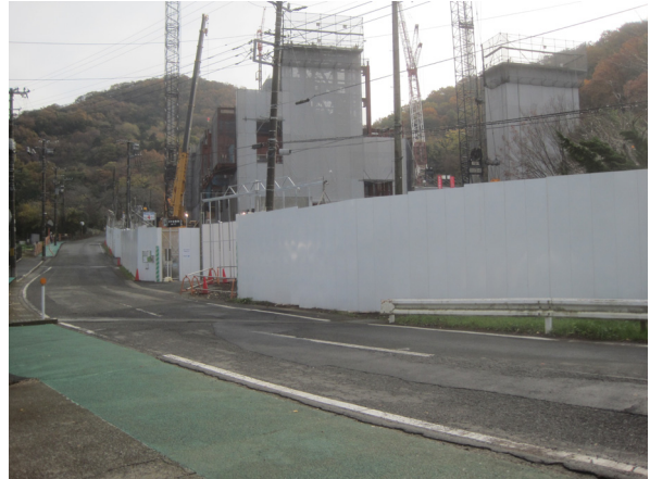
図3.2-2 仮囲いの設置状況
